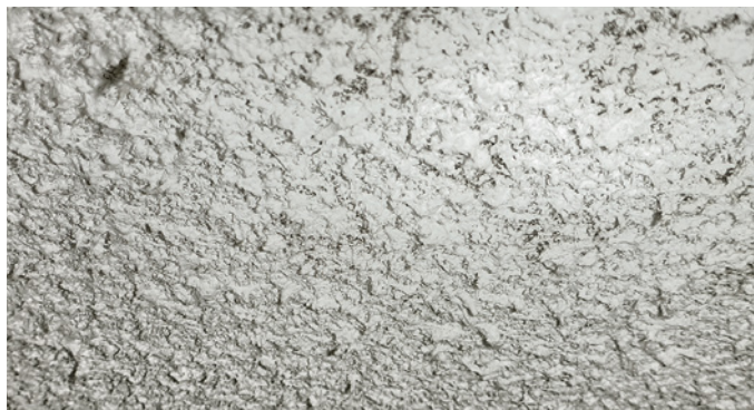
Intonaco fonoassorbente contenente amianto
