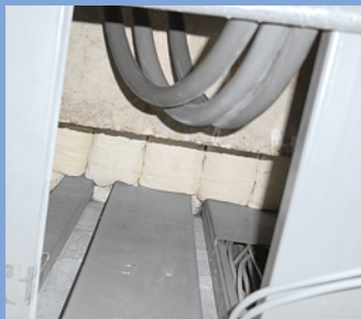
Barriera antifiama con cuscini di amianto
