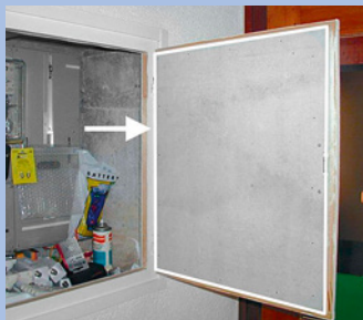
Pannello antincendio contenente amianto
