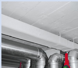
Canalina per cavi in fibrocemento
