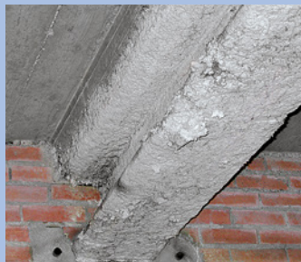
Isolamento in amianto spruzzato
