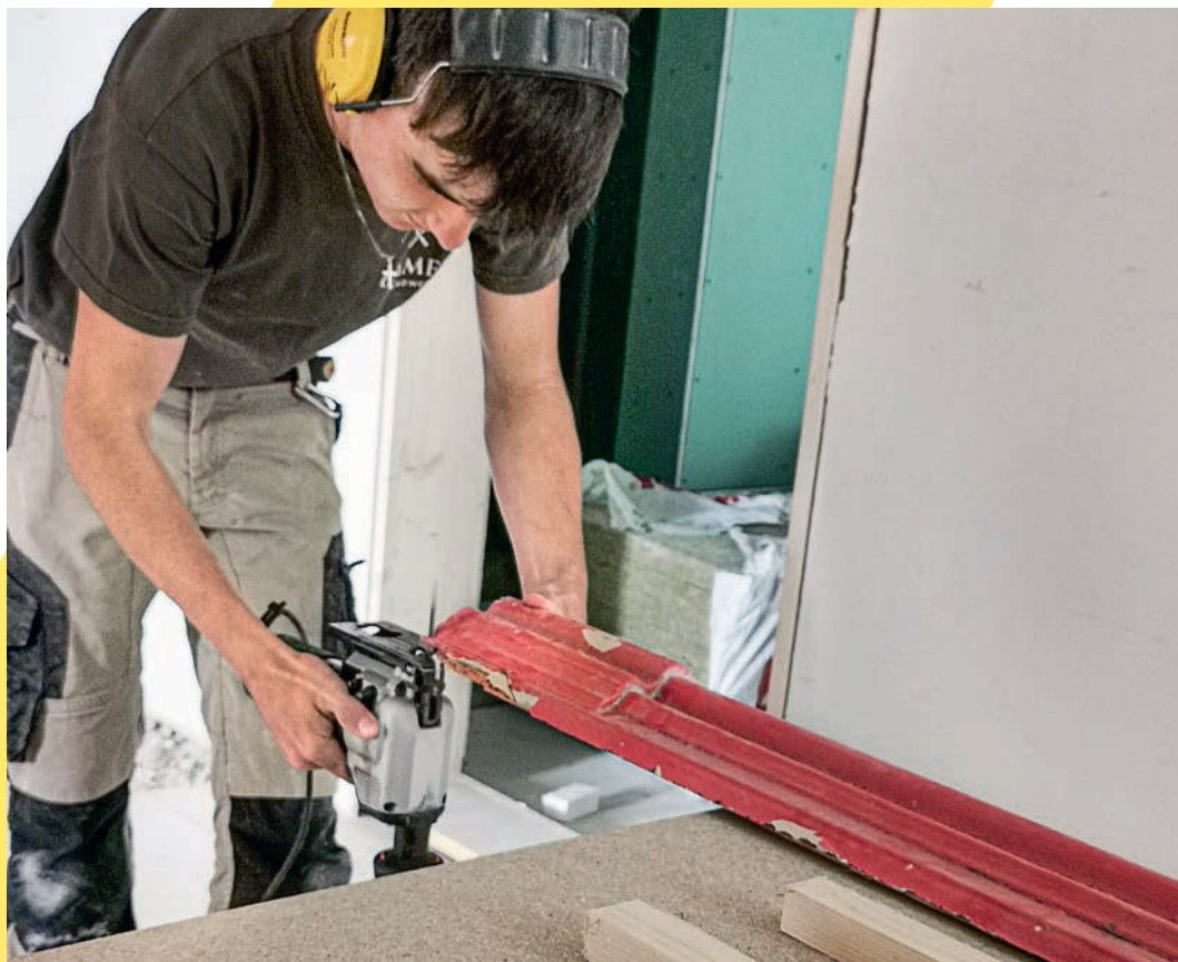
Claudio Bischof bearbeitet auf der Baustelle einen alten Türrahmen.
