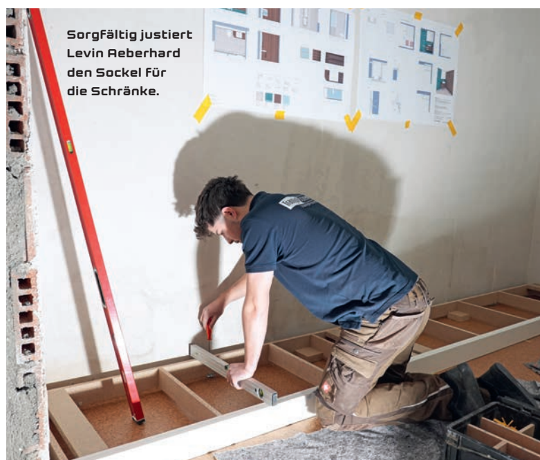
Mael Dysli (l.) und Levin Aeberhard (r.) helfen sich gegenseitig beim Ausrichten der Einbauschränke.
